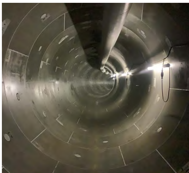
バイパス管完成
