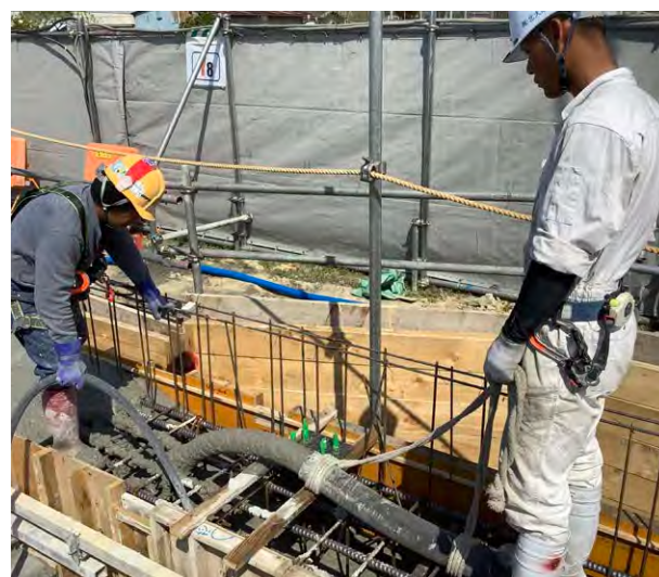
環境配慮型コンクリート(BB+FA) 打設状況
