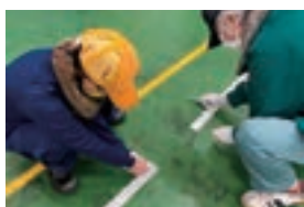
床ラインテープ補修
