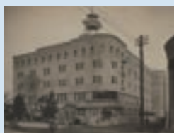
1930年 旧江戸橋倉庫ビル
