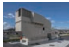
大阪・茨木5号配送センター 非常用発電機
