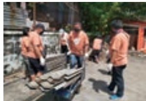
小学校修繕の様子
