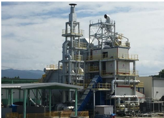
【錦町 2 MW 木質バイオマス発電所】
