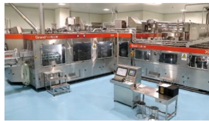
東洋飲料(常熟)有限公司： 2022年12月に新たに稼働した5本目の無菌充填ライン
