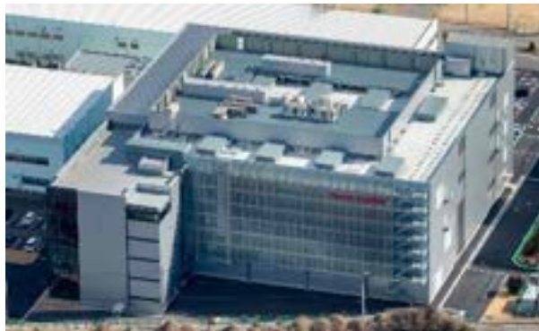
八幡原工場材料棟(群馬県高崎市)
