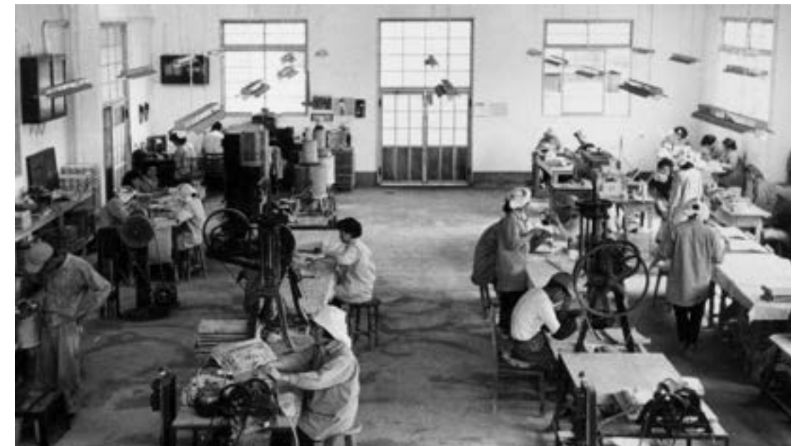
1957年頃の素地工場（高崎工場）
