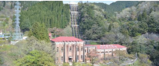
水力発電(東横山発電所)
