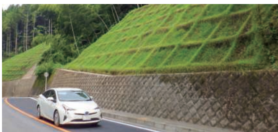
GTフレーム工法 ® によるのり面
