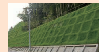
のり面事業(GTフレーム工法) [イビデングリーンテック(株)]
