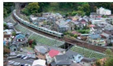
盛土のり面の防災対策
