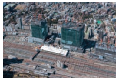
TAKANAWA GATEWAY CITY(建設中)
