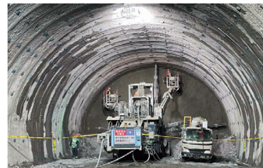
伊那山地トンネル（青木川工区） 本線トンネルの掘削（中央構造線部）
