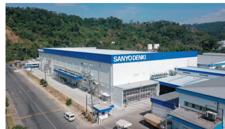
SANYO DENKI PHILIPPINES, INC. 第4工場 外観
