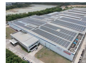
EIT(タイ) 太陽光パネル 追加設置
