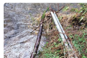
プキトラウエ川の取水口
