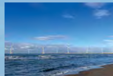
石狩湾新港洋上風力発電所建設工事 規模 : 112MW (8MW×14基)
