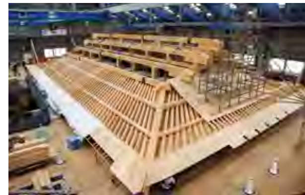
首里城正殿復元整備工事（沖縄県那覇市） 小屋（屋根内部）を構成する木材の建て方が進む素屋根の中 ※ 写真は2024年3月時点
