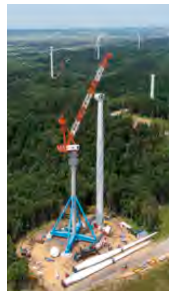
国内最大の陸上風車建設用移動式タワークレーンを使っている施工状況
