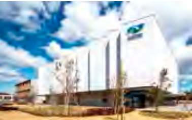
土浦テクノBASE(茨城県土浦市)
