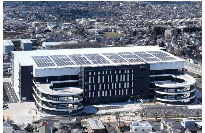
GLP 上尾ソーラー発電所
