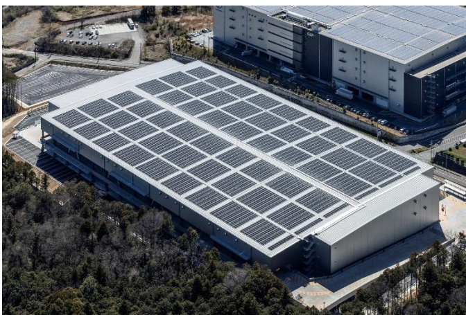
GLP 狭山日高川ソーラー発電所
