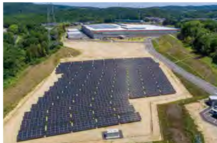
日東工業瀬戸工場 (愛知県瀬戸市)
