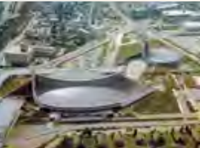
1964 国立屋内総合競技場主体育館 世界に類を見ないワイヤーロープ による吊り屋根構造
