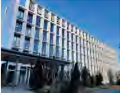
PCaを活用し 洗練されたフォルムを持つ 順天堂浦安病院 (千葉県浦安市)
