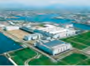
2009 グリーンフロント界 環境先進型の液晶パネル工場
