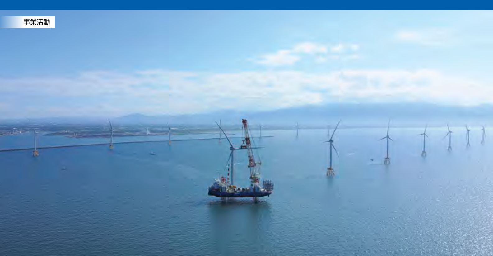
石狩湾新港洋上風力発電所の風車建設(北海道石狩湾新港港湾内)
