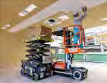
スカイランナー(右)・スカイテーブル(左)を利用した天井仕上げ作業
