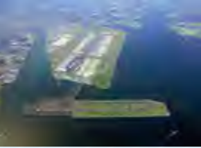
2010 東京国際空港D滑走路 世界でも珍しい埋立と栈橋のハイ ブリッド構造を採用した大規模海 上滑走路 (画像提供:羽田再拡張D滑走路JV)
