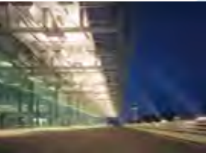
2007 チャンギ国際空港第3ターミナル (シンガポール) 幅300m×奥行215mの鉄骨 トラスのリフトアップは世界初
