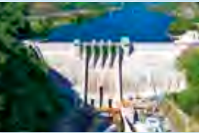
2020 ハッ場ダム 当社初の堤高100m超えの大型ダ ム。プレキャストやICTなどの積極 活用により大幅な工期短縮を実現
