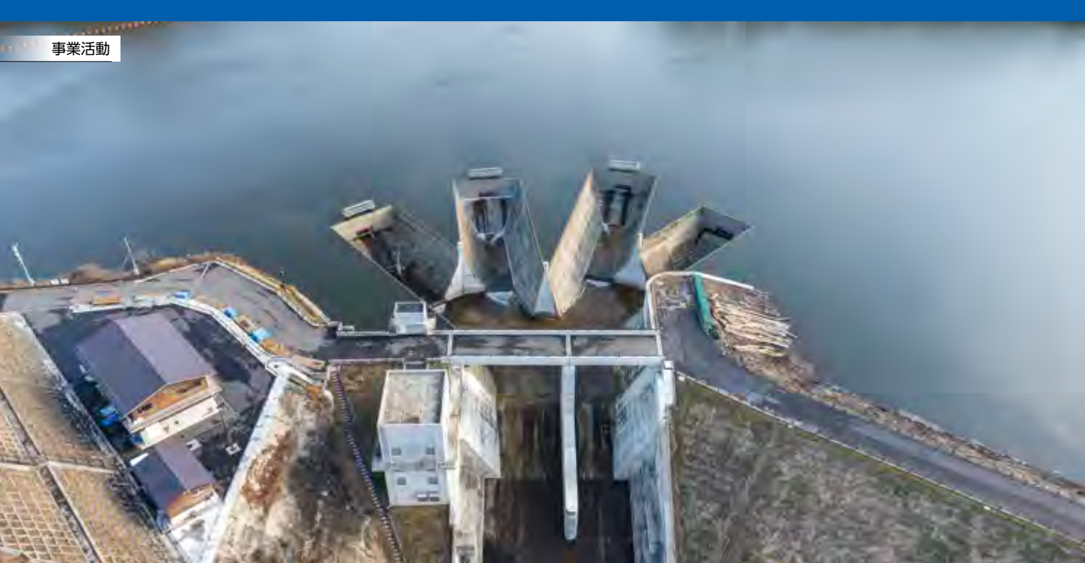
千五沢ダム再開発工事（福島県石川町） ラビンス型洪水吐による治水機能付加工事を実施
