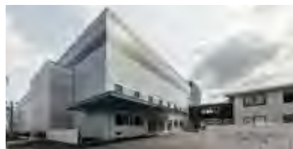
進工業小浜工場 (福井県小浜市)
