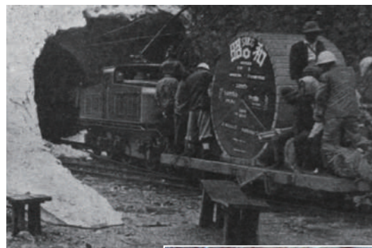
黒部川送電工事 (1956年撮影)
