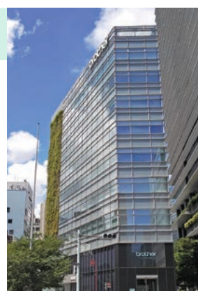
プラザ東京ビルZEB化プロジェクト(リニューアル) (2023年 東京都)
