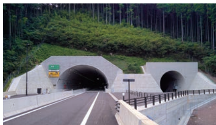
二重峠トンネル(阿蘇工区) (2020年 熊本県)
