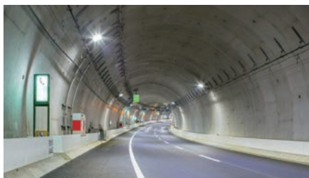
横浜環状北西線シールドトンネル (2019年 神奈川県)
