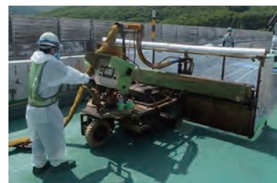
バインダ散布ロボットを活用したHQ/ハイプレッスAU工法
