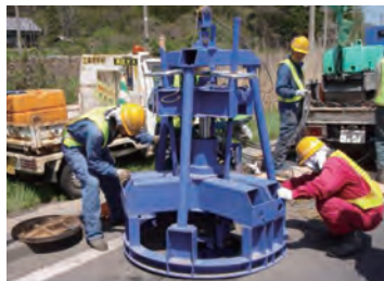
施工状況(マンホールの撤去)
