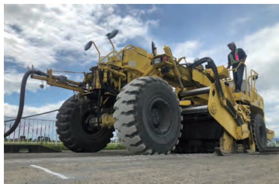
ロードスタビライザによる施工状況
