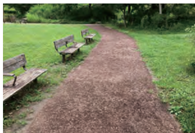
ナラ枯れ被害木を用いたアスウッド舗装
