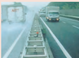
4 雨天時の水はねを抑制し、視認性を高め安全に寄与する「タフファルトスーパー」
