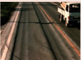
2 モータリゼーションの進展により生じたわだち掘れの対策に「ポリファルトSS」
