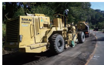
ICT技術を活用したスタビセメントRC工法
