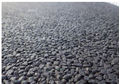
小粒径ポーラスアスファルト混合物(5)を用いた舗装
