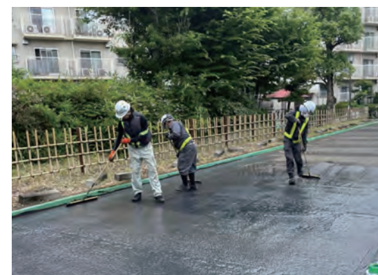
人力による施工状況
