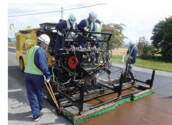
専用車両による敷き均し状況
