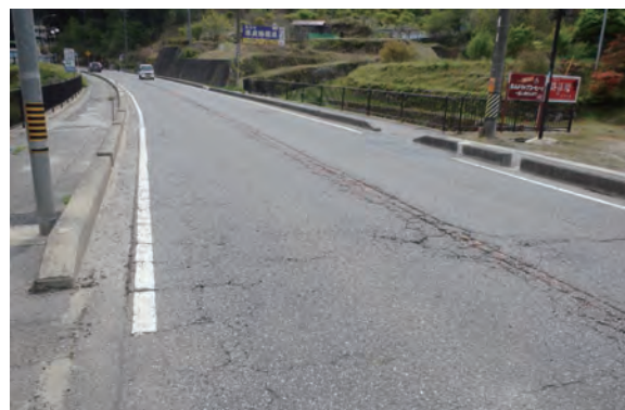
破損が進行した既設舗装
