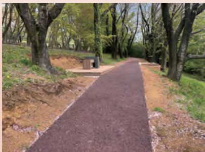
ウッドチップ舗装 「アスウッド舗装」
