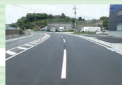
アスファルト舗装
