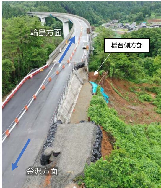
施工前の状態
