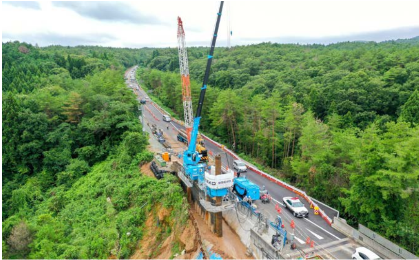
片側交互通行を維持しながら施工
