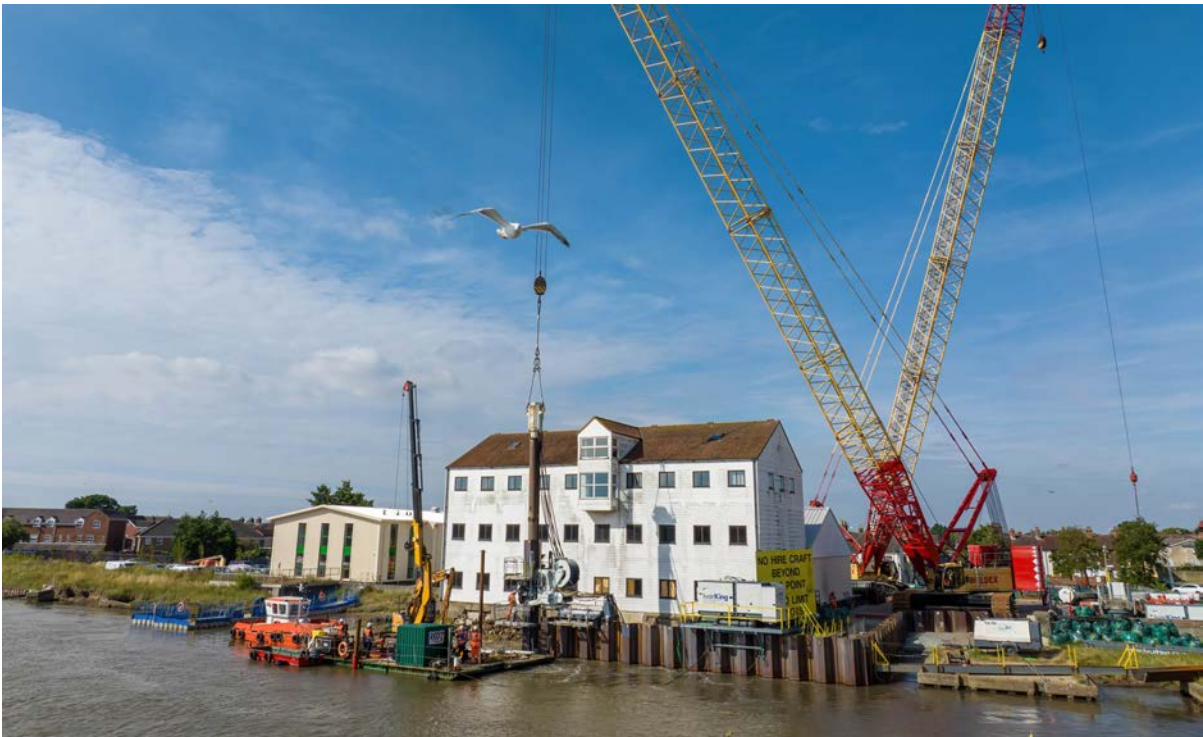
「GTOSS™」を締結したイギリスの Ivor King (C.E.C.) Ltd.による圧入施工の様子
