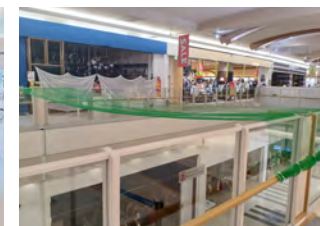
天井崩落対策に向けた安全対策ネット
