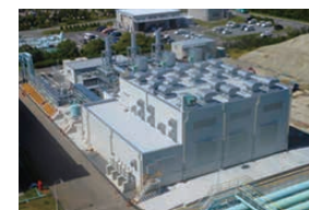
四日市発電所
