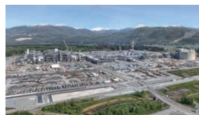
LNGカナダプロジェクト（建設中）
