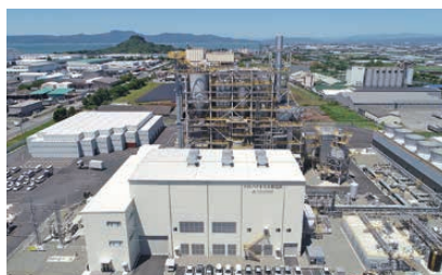
八代バイオマス発電所
