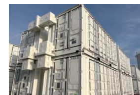
津蓄電所（建設中）
