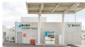
豊田豊栄水素ステーション
