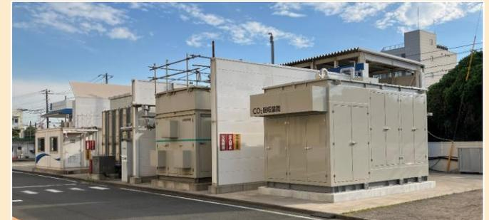
川崎製作所内に設置した二酸化炭素回収装置実証機(手前)
