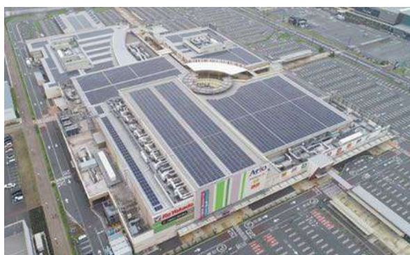
屋根上太陽光パネル（Ario 市原店）
