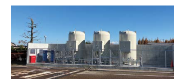
北陸工場のボイラー燃料転換
