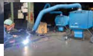
工場内の粉塵対策の実施
