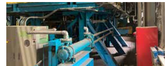
既存設備への振動対策の実施
