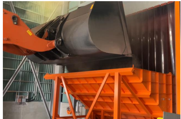
燃料投入ホッパへ PKS を投入している様子
