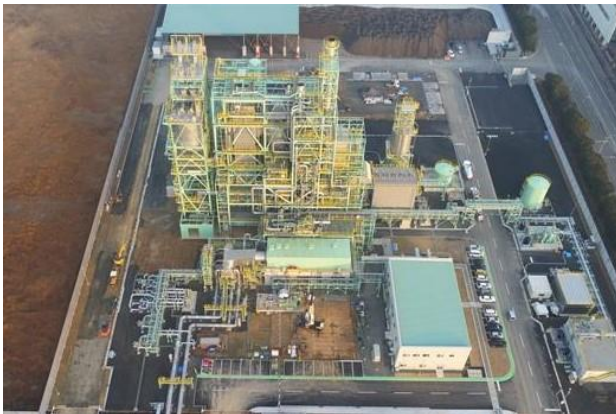
発電所全景（南側から北側を望む）
