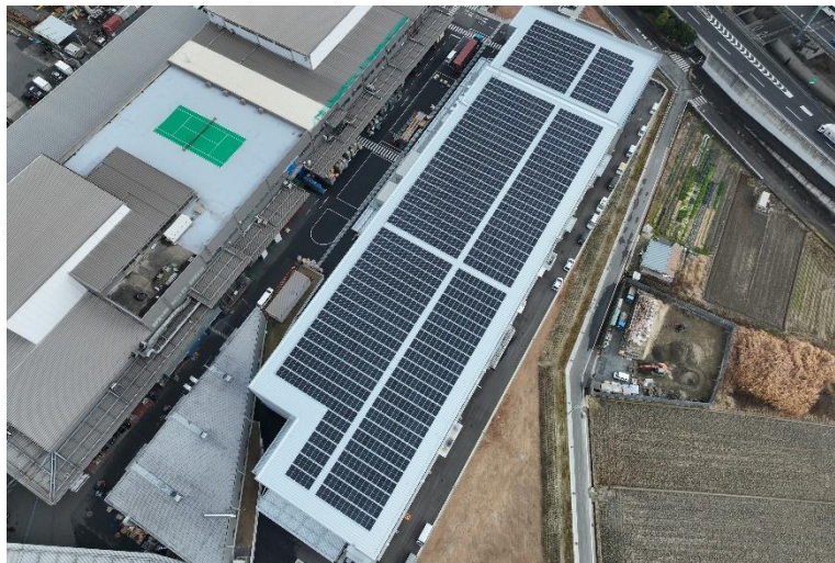
鶴見製作所 京都工場 太陽光発電システム
