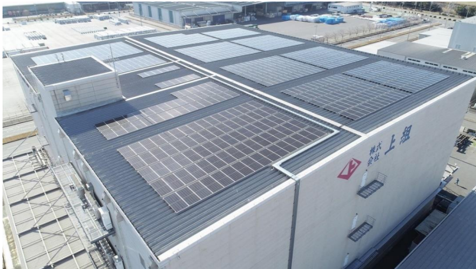
上組 弥富物流センター 太陽光発電システム
