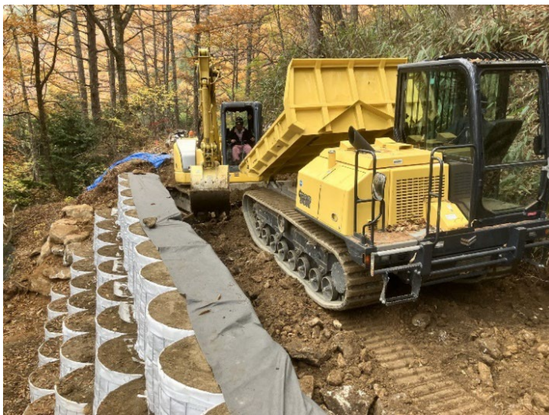
山間部における「ソイルセメントを利用した円形コンバック」の施工事例
