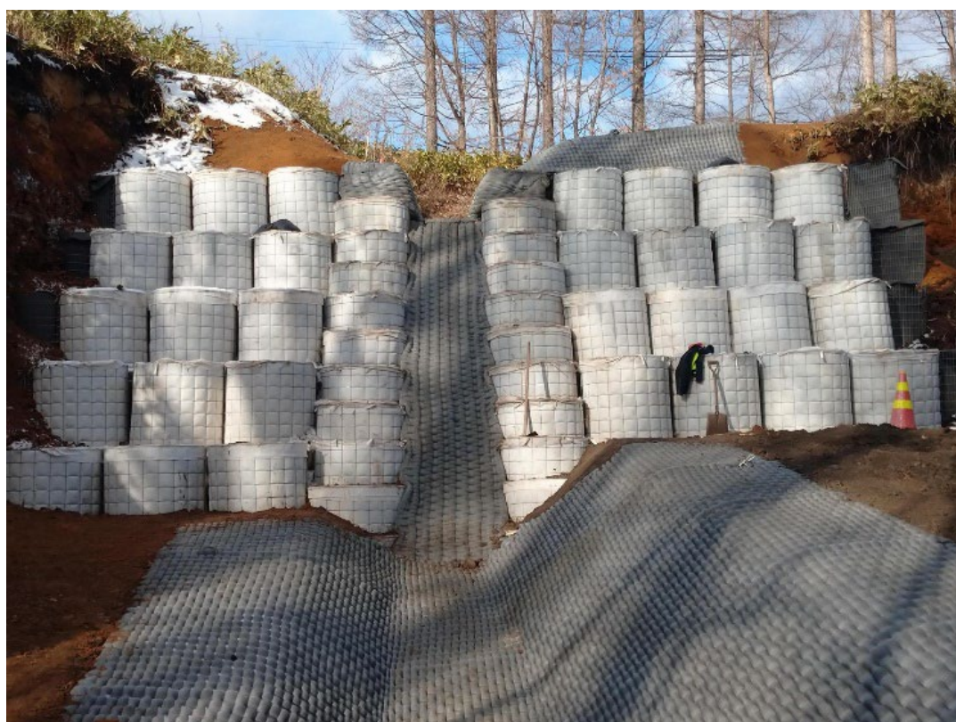
「円形コンバック®」施工事例
