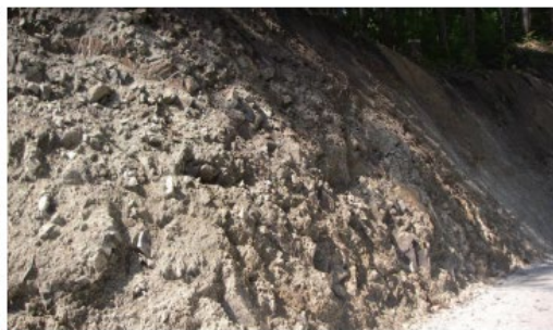
▲ 施工前（秋田県の林道工事）
