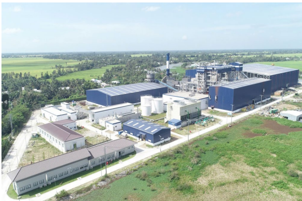
ハウジャンバイオマス発電所
