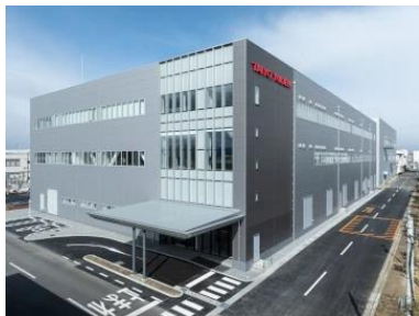
2025年2月竣工 玉村工場 5号棟 (群馬県佐波郡)
