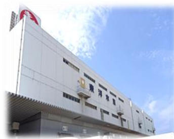
フロン冷媒設備 更新工事
