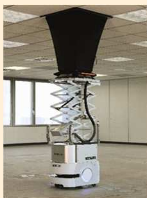
● ロボットを活用した現場の省力化
