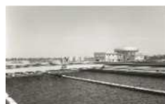
埼玉県 大久保 浄水場
