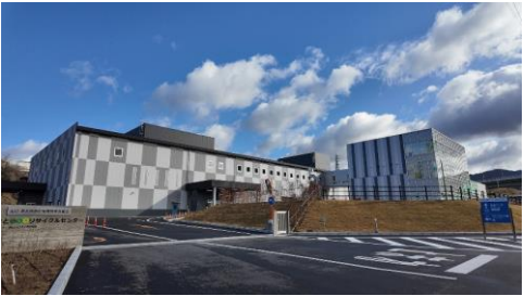
奈良県天理市 山辺・県北西部広域環境衛生組合 やまとecoリサイクルセンター (DBO案件)
