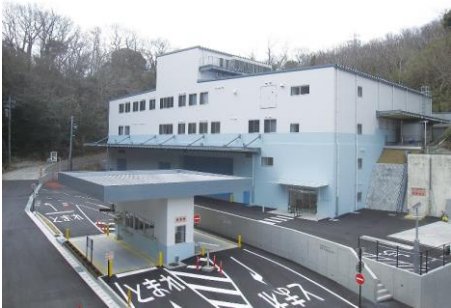
神奈川県中郡大磯町 大磯町美化センターリサイクルセンター (DBO案件)
