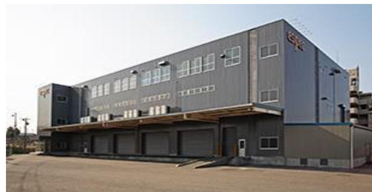
豊田試験所(愛知県豊田市)
