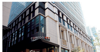
室町古河三井ビルディング
