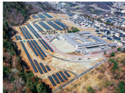
山梨大月太陽光発電所 オフサイトPPA契約により工学院大学に電力供給
