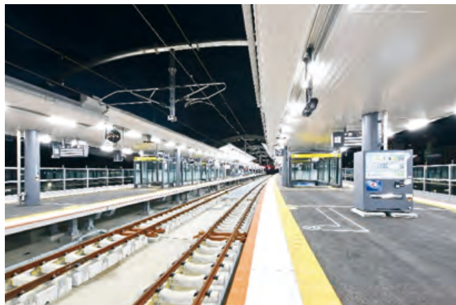
南方から3番線ホームを望む
