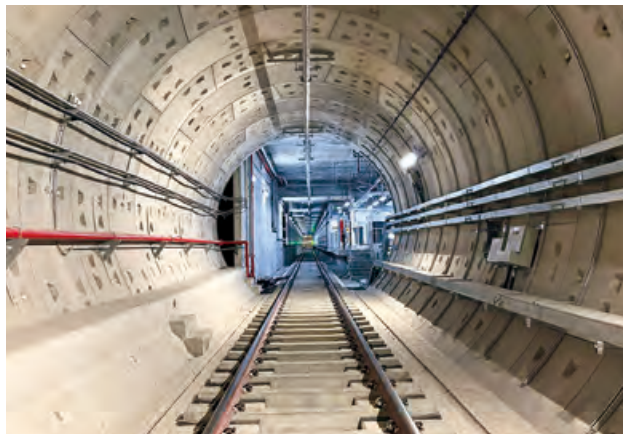
シールドトンネル内よりオペラハウス駅を望む
