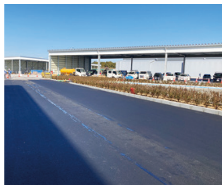
バイオ炭アスコン施工事例
