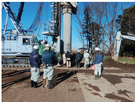
CP-X工法 現場施工試験 委員会立会状況
