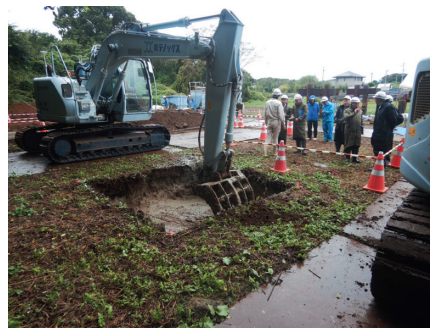
テノキューブ工法 現場施工試験 委員会立会状況
