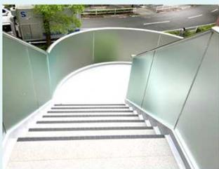
経年や風雨により劣化していた外階段を改修。安全性能が向上したほか、女性利用者への配慮として側面にスモークガラスを採用しました
