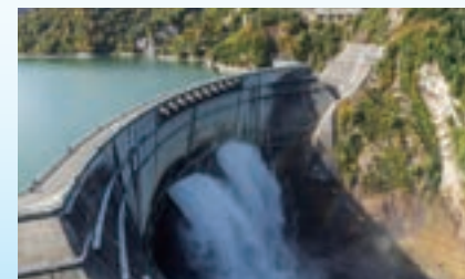
水力(揚水)発電所
