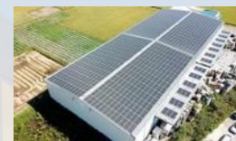
自家消費／武智発電所 容量：417.45kW
