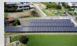
津島下新田発電所 容量：106.5kW
