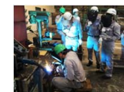
↑鉄骨資材研修での溶接実習
