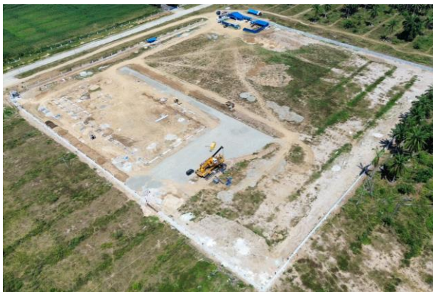
本工場の建設場所 全景
