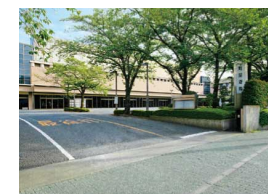
町屋斎場 (荒川区)
