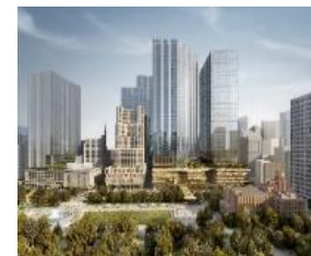
南地区 (サウスタワー)
