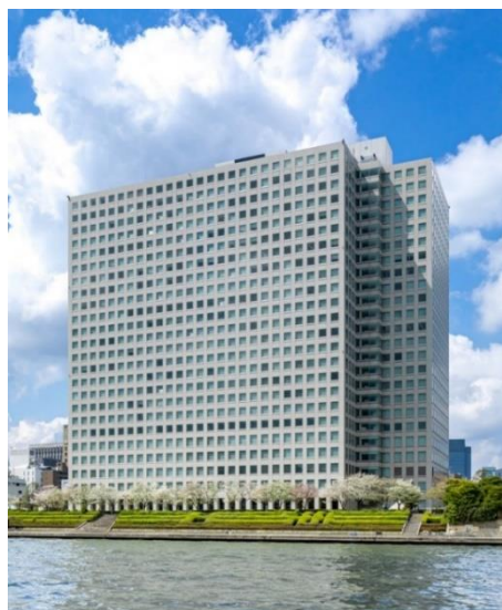
(MSH日本橋箱崎ビル 外観)
