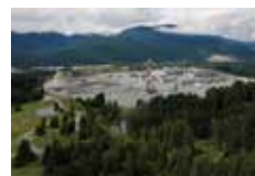
LNGカナダプロジェクト
