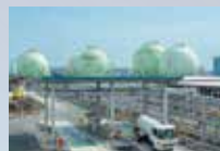
東邦液化ガス(株) 名港LPG基地
