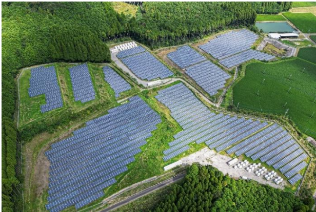
蓄電池設置後の発電所全景
