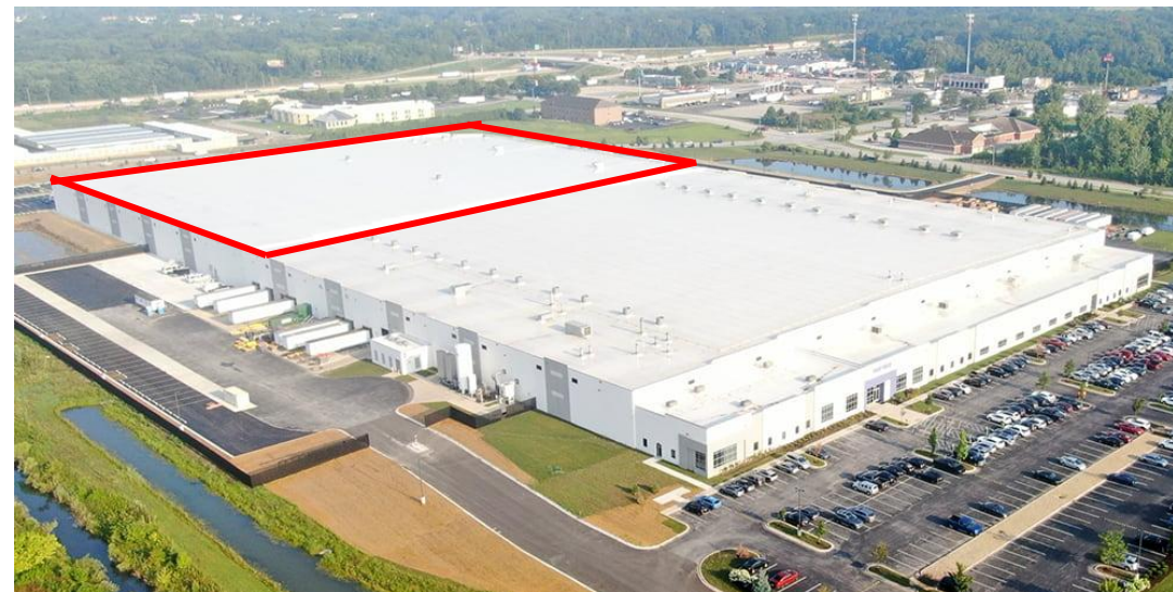
既存工場棟に隣接する米国の新工場棟 (赤枠)
